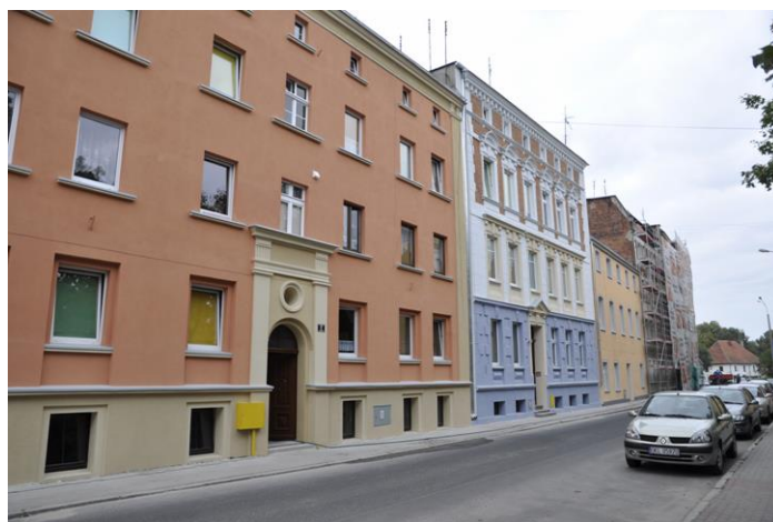
Zdjęcie 4 Jedna z kamienic przy ul. Damrota. po remoncie. Źródło: Urząd Miejski w Kluczborku
