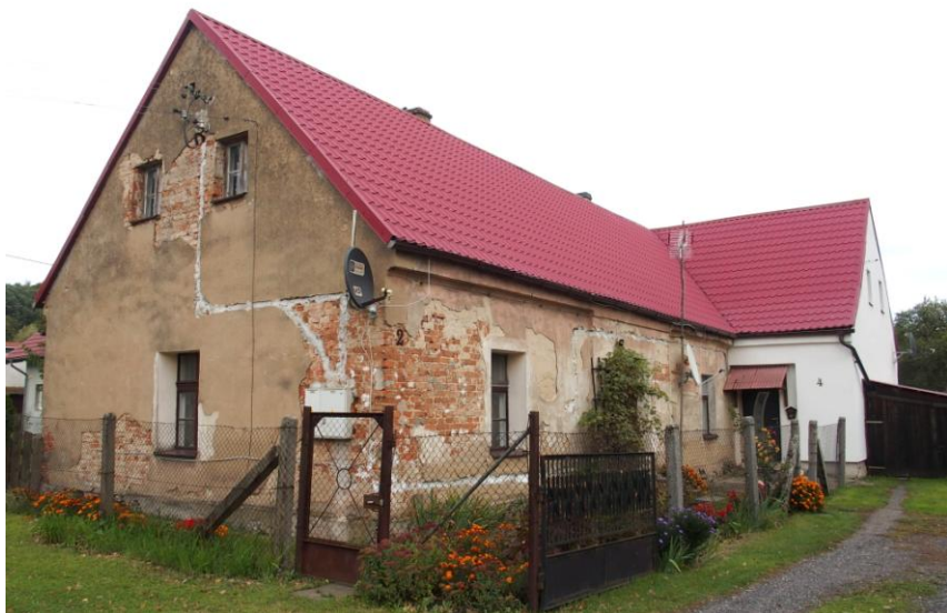
Widok budynku od północnego - zachodu
