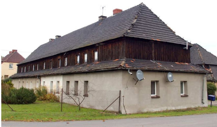
Widok budynku od południowego - zachodu
