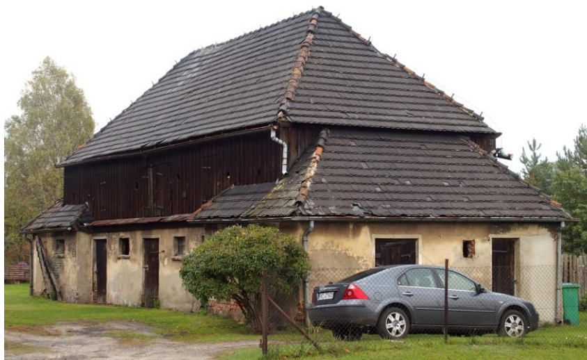
Widok budynku od południowego - zachodu
