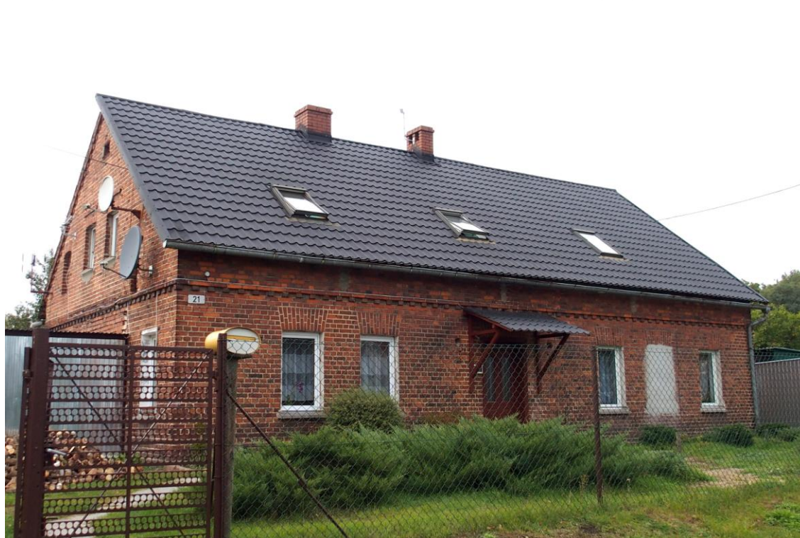
Widok budynku od południowego - wschodu
