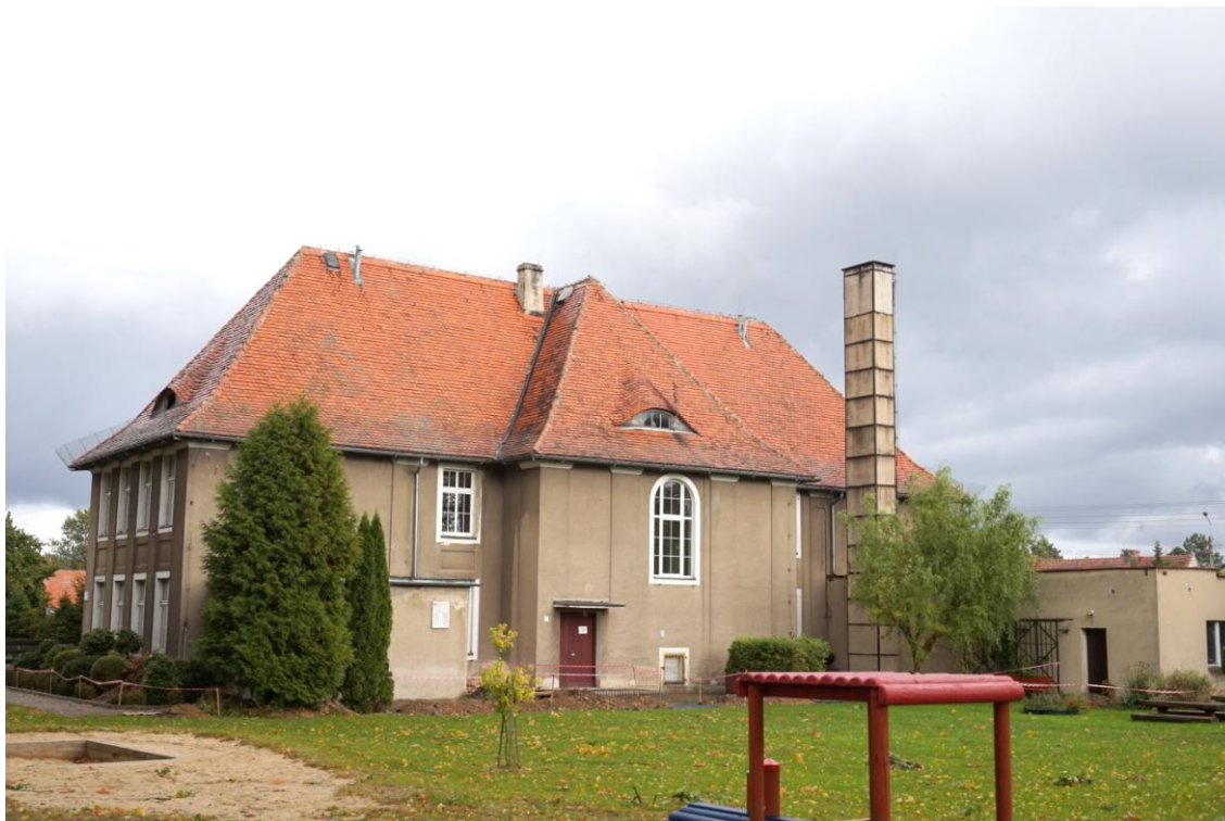
Widok budynku od północnego - zachodu
