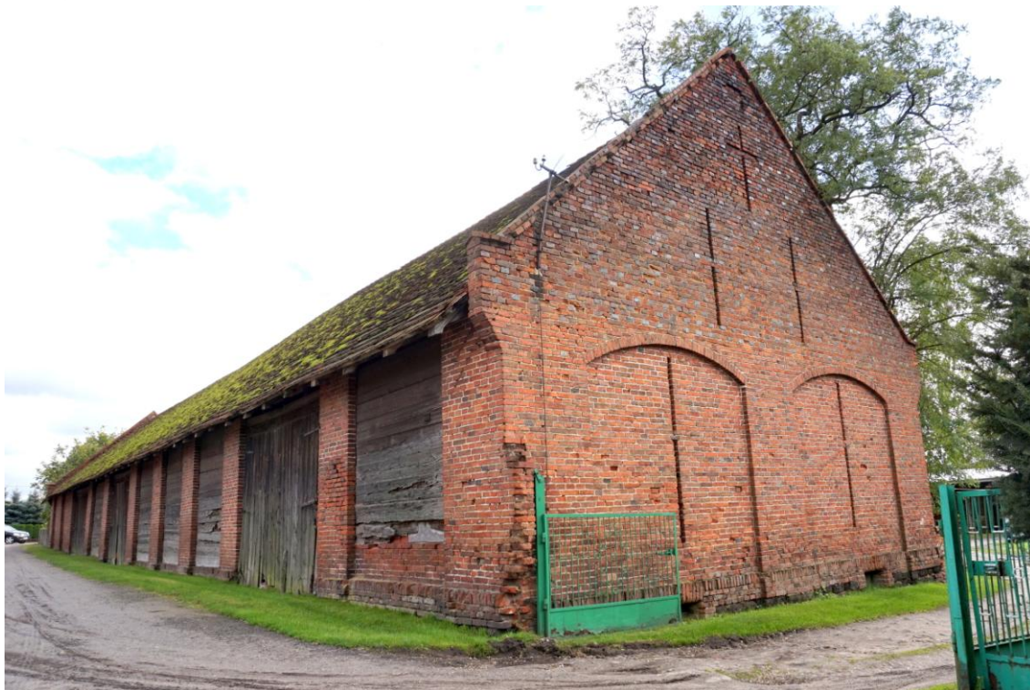
Widok budynku od północnego - zachodu
