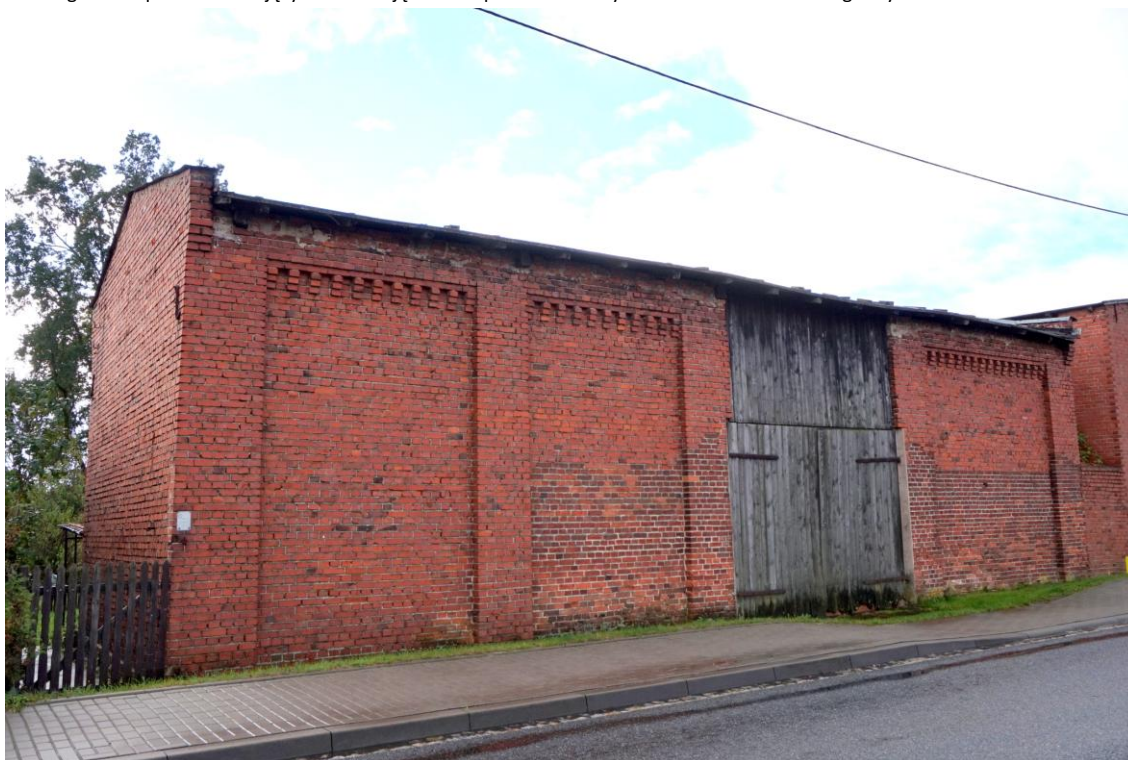
Widok budynku od północy
