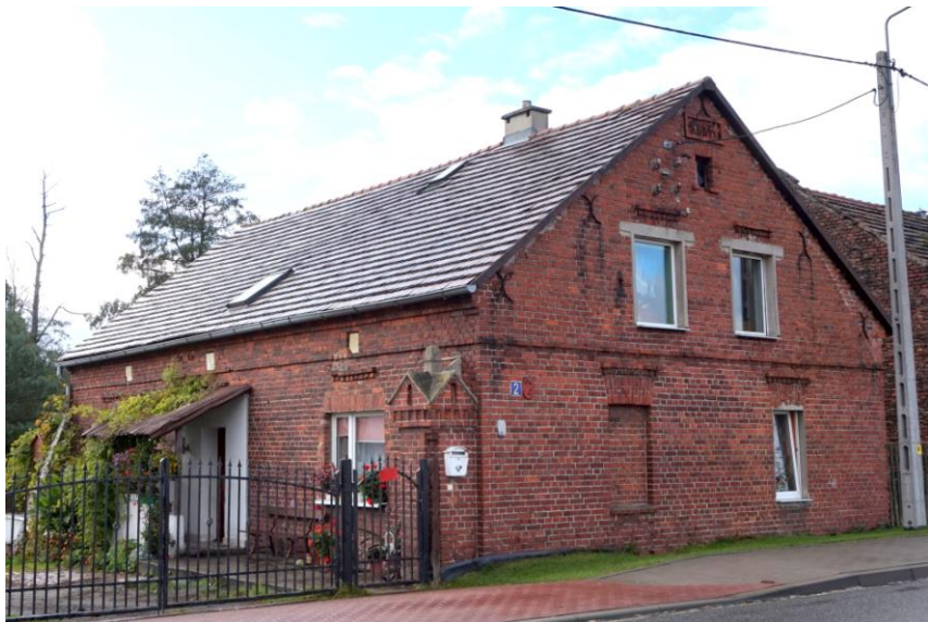
Widok budynku od północnego - wschodu
