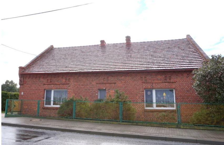
Widok budynku od północy
