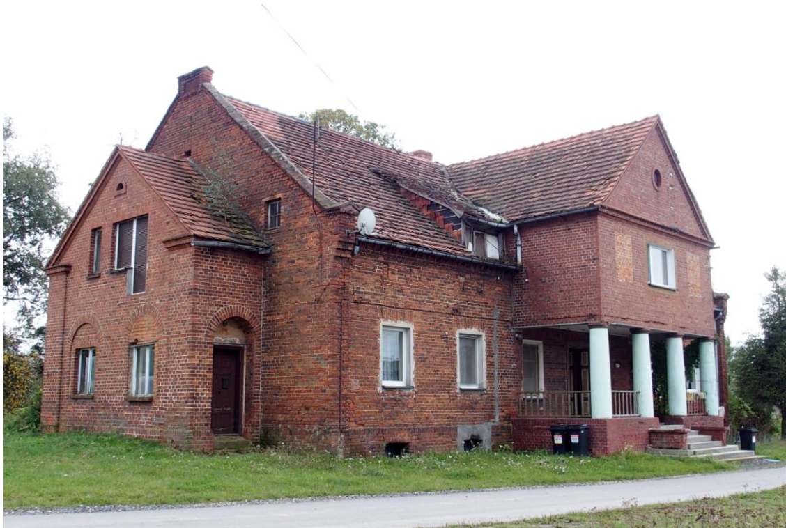
Widok budynku od północnego - zachodu
