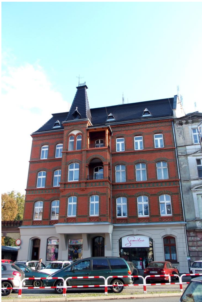
Widok budynku od północy
