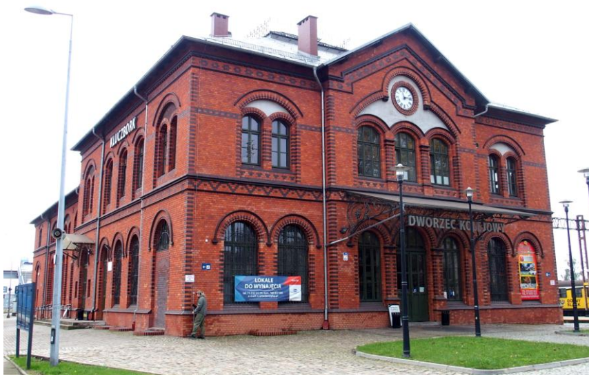
Widok budynku od północnego - zachodu
