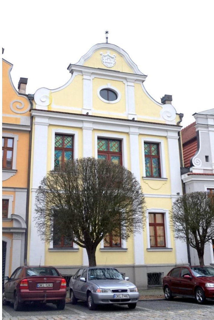
Widok budynku od północy
