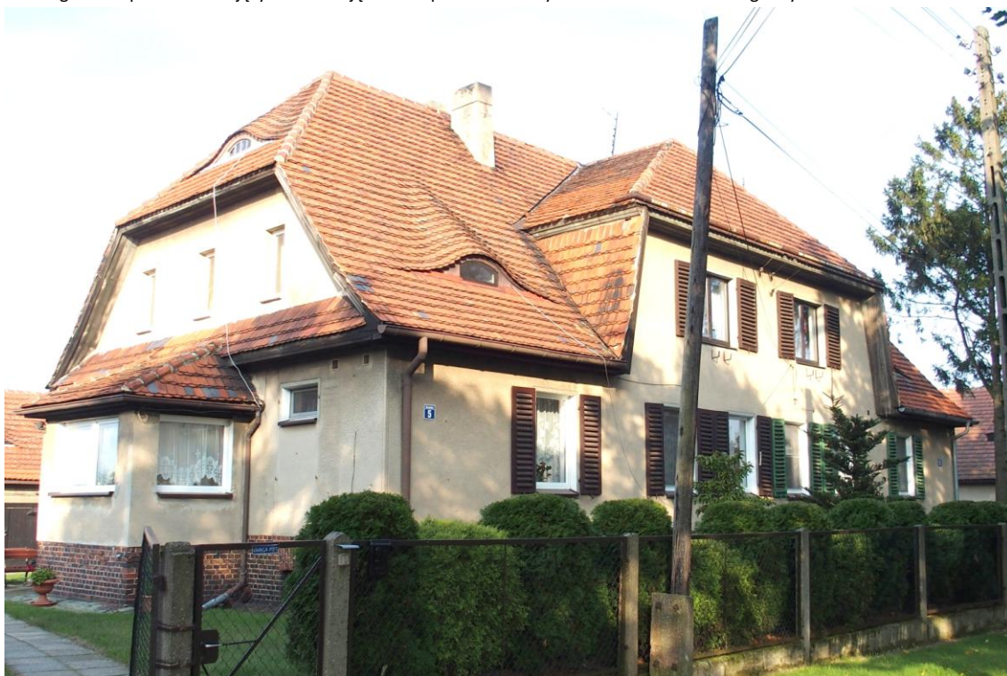
Widok budynku od południowego - zachodu
