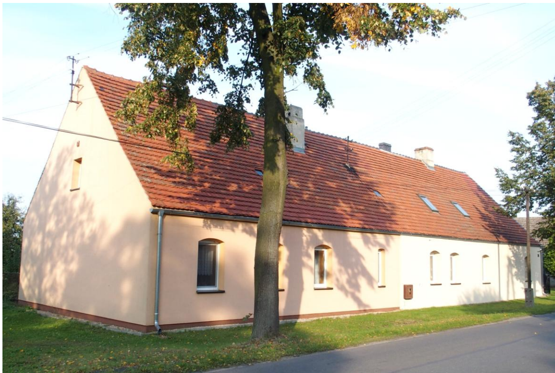
Widok budynku od południowego - zachodu
