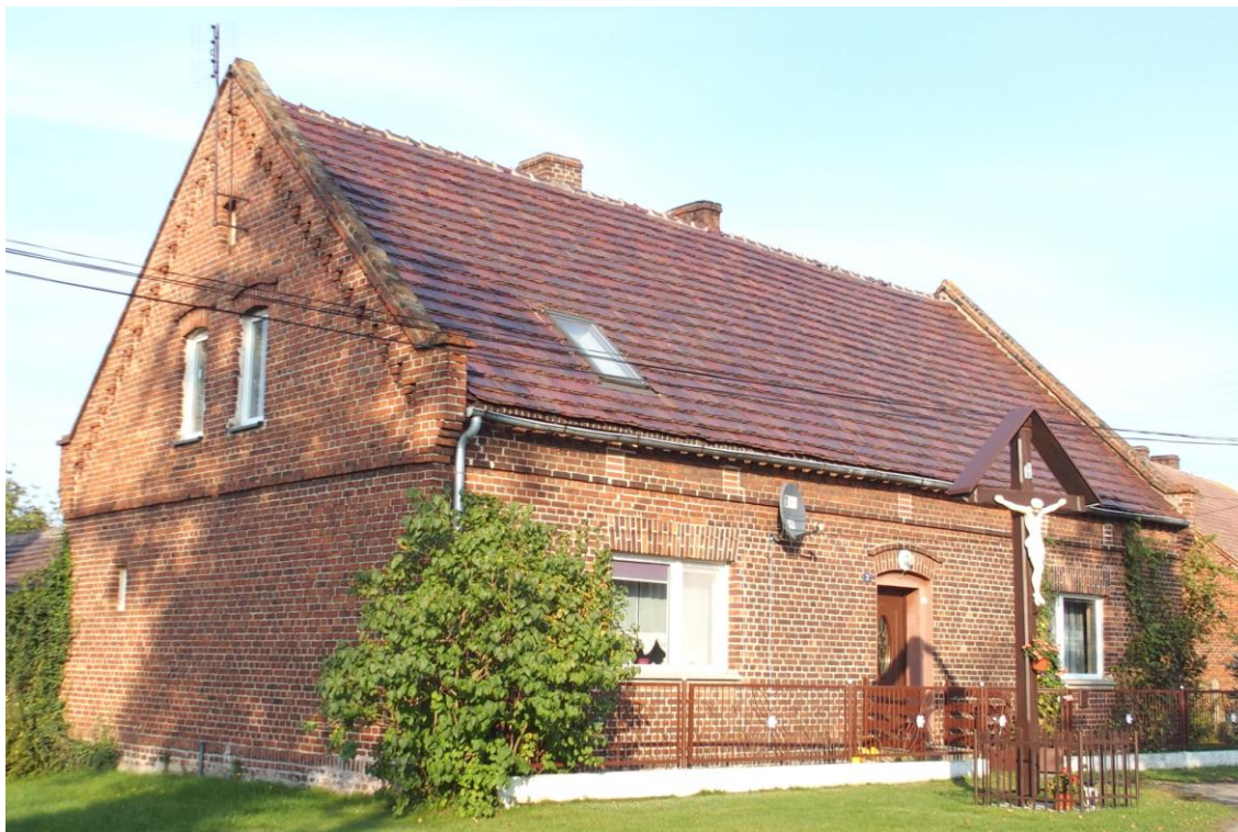
Widok budynku od południowego - zachodu
