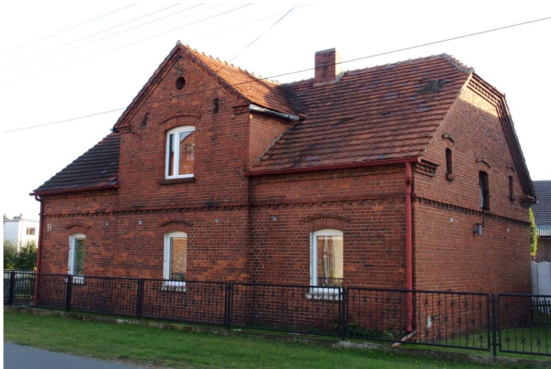
Widok budynku od północy
