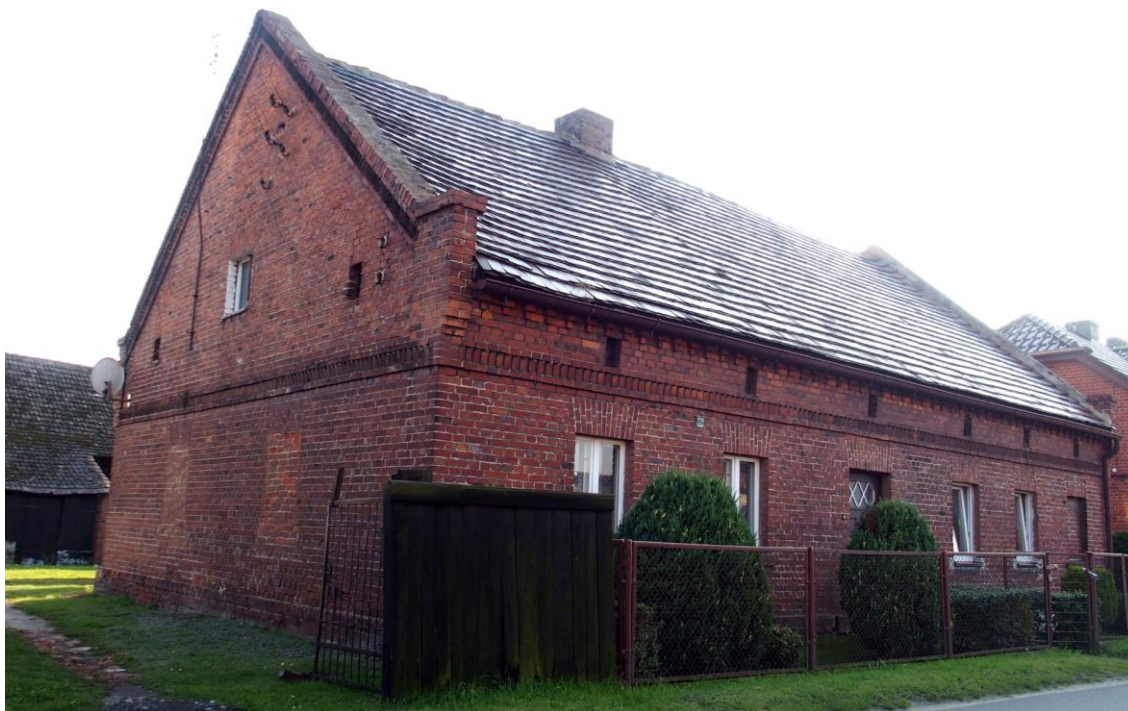
Widok budynku od północnego - wschodu
