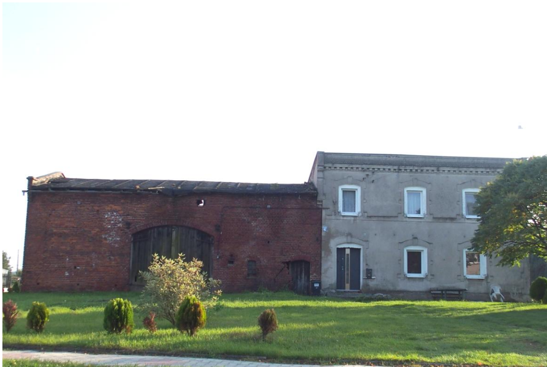
Widok budynku od północy
