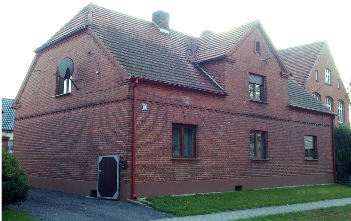
Widok budynku od północnego - wschodu
