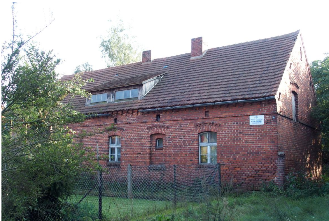
Widok budynku od północy
