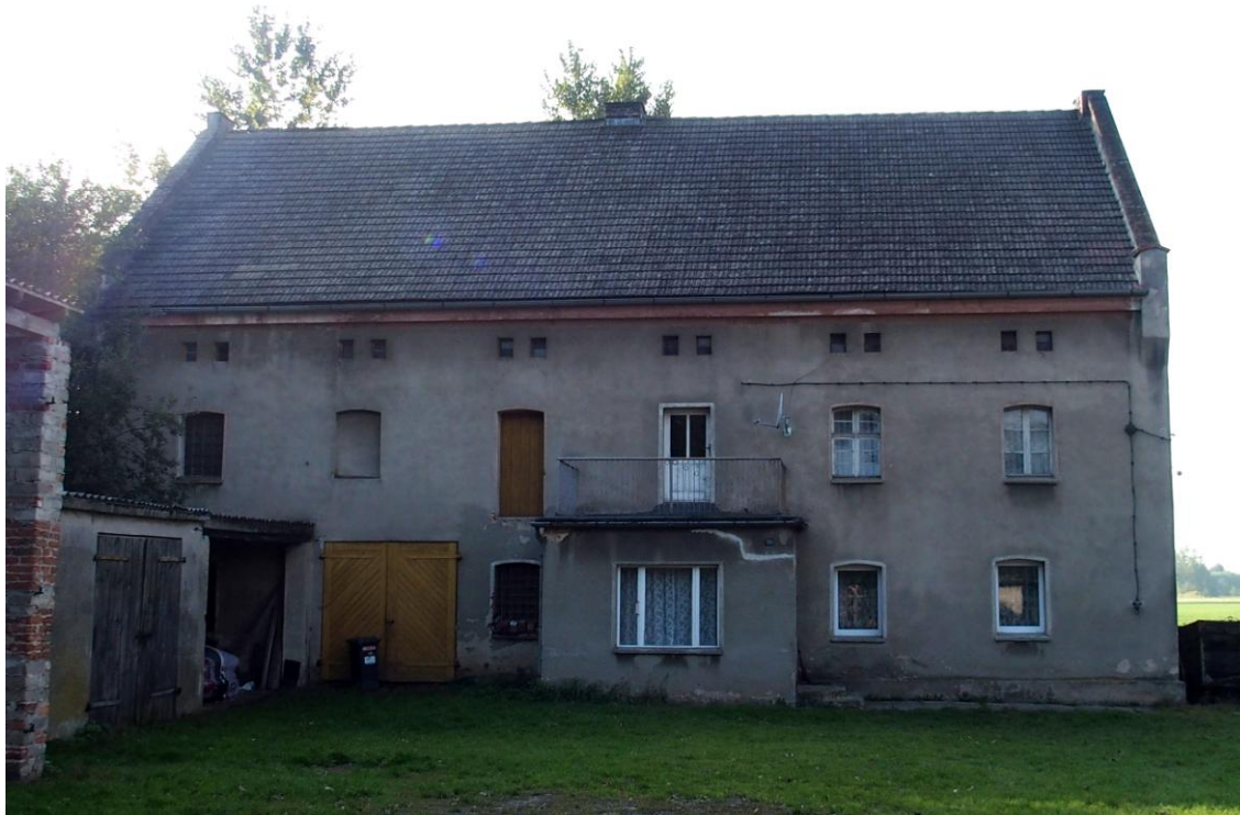
Widok budynku od wschodu
