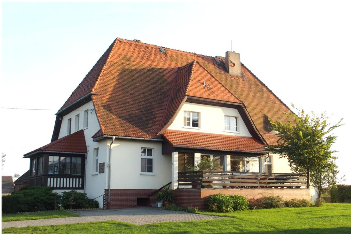
Widok budynku od północy
