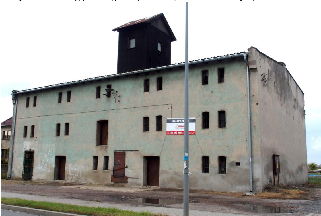
Widok budynku od południowego - wschodu
