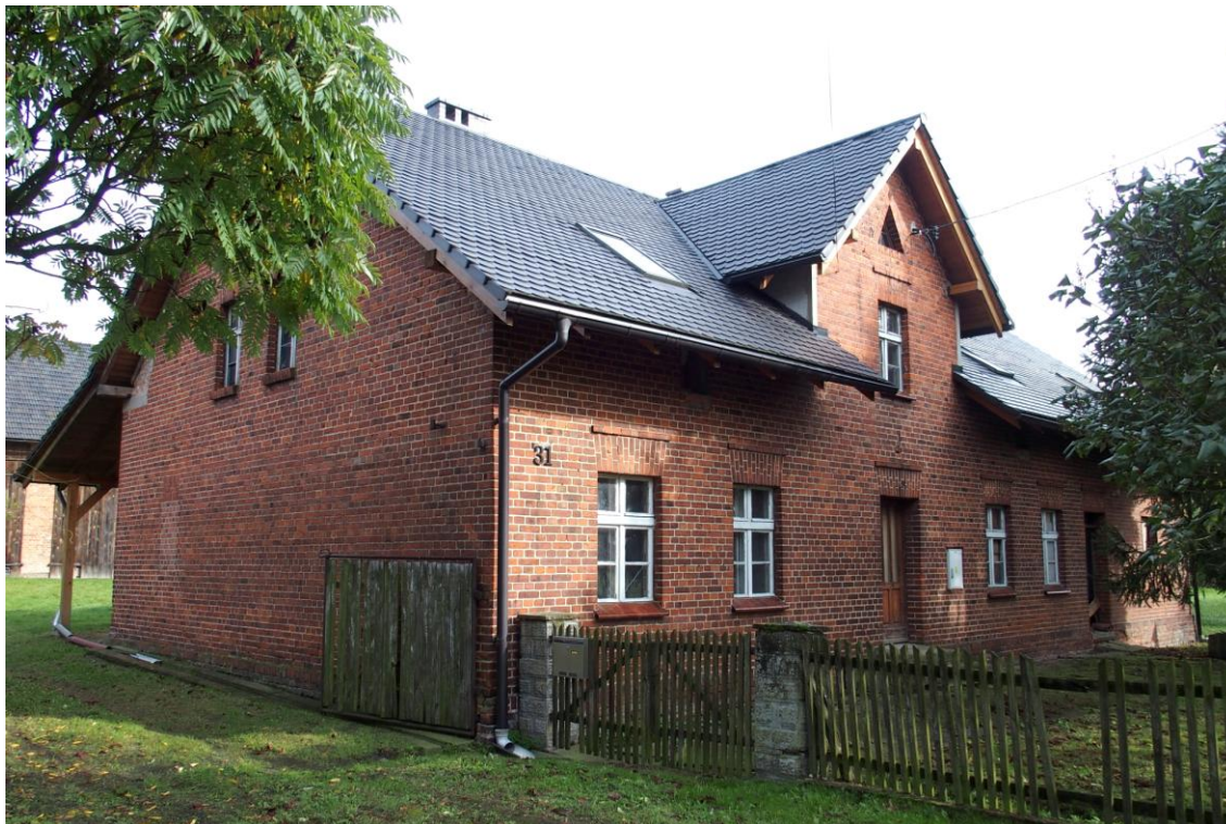
Widok budynku od południowego - zachodu
