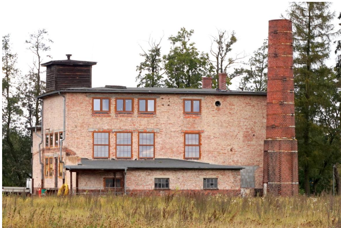
Widok budynku od wschodu
