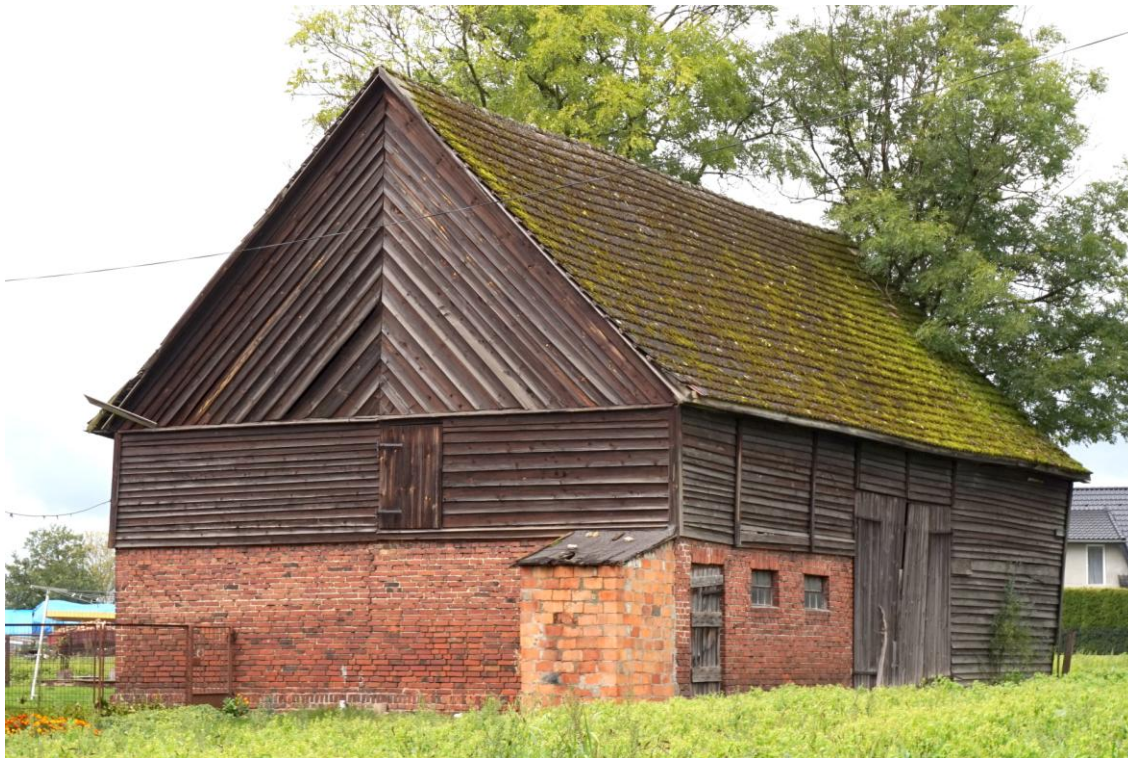
Widok budynku od wschodu
