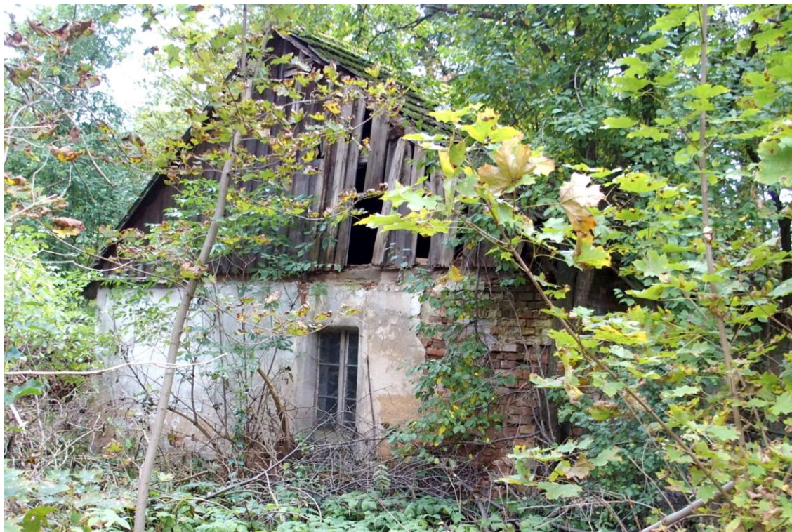
Widok budynku od północnego - wschodu
