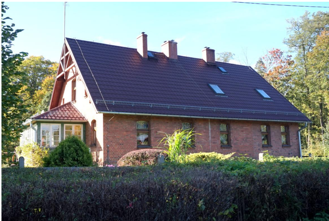
Widok budynku od południowego - wschodu
