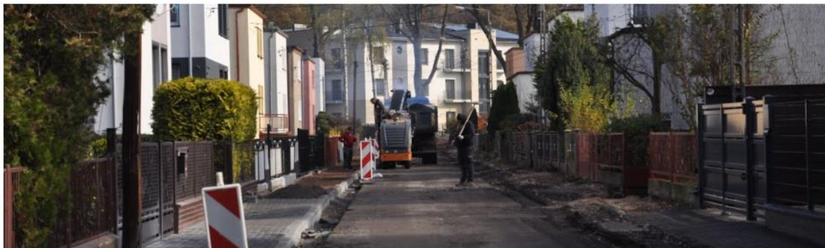
Ul. Kwiatowa w remoncie
