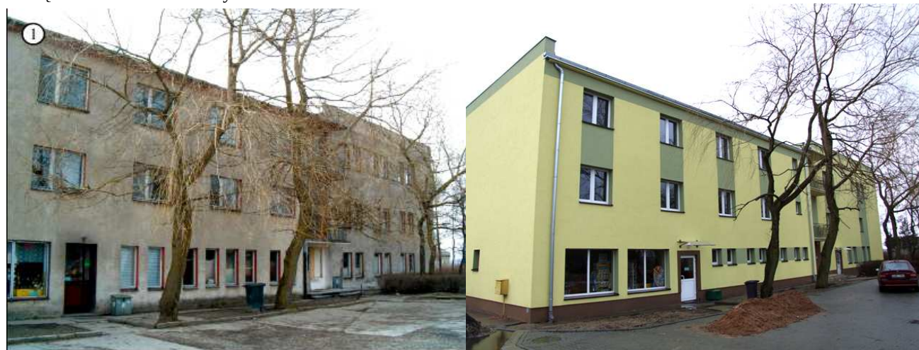
Zdjęcie 4. Adaptacja budynku w Gotartowie (przed i po) – koszt 1 300 000 zł, 20 mieszkań. Źródło: Miejski Zarząd Obiektów Komunalnych w Kluczborku
