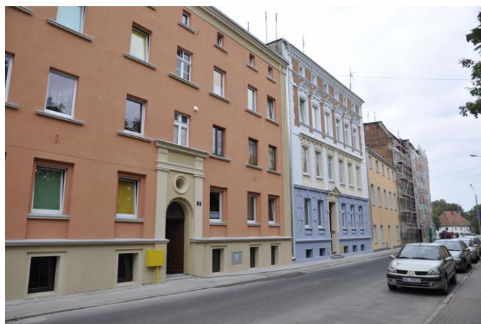
Zdjęcie 4 Jedna z kamienic przy ul. Damrota. po remoncie. Źródło: Urząd Miejski w Kluczborku
